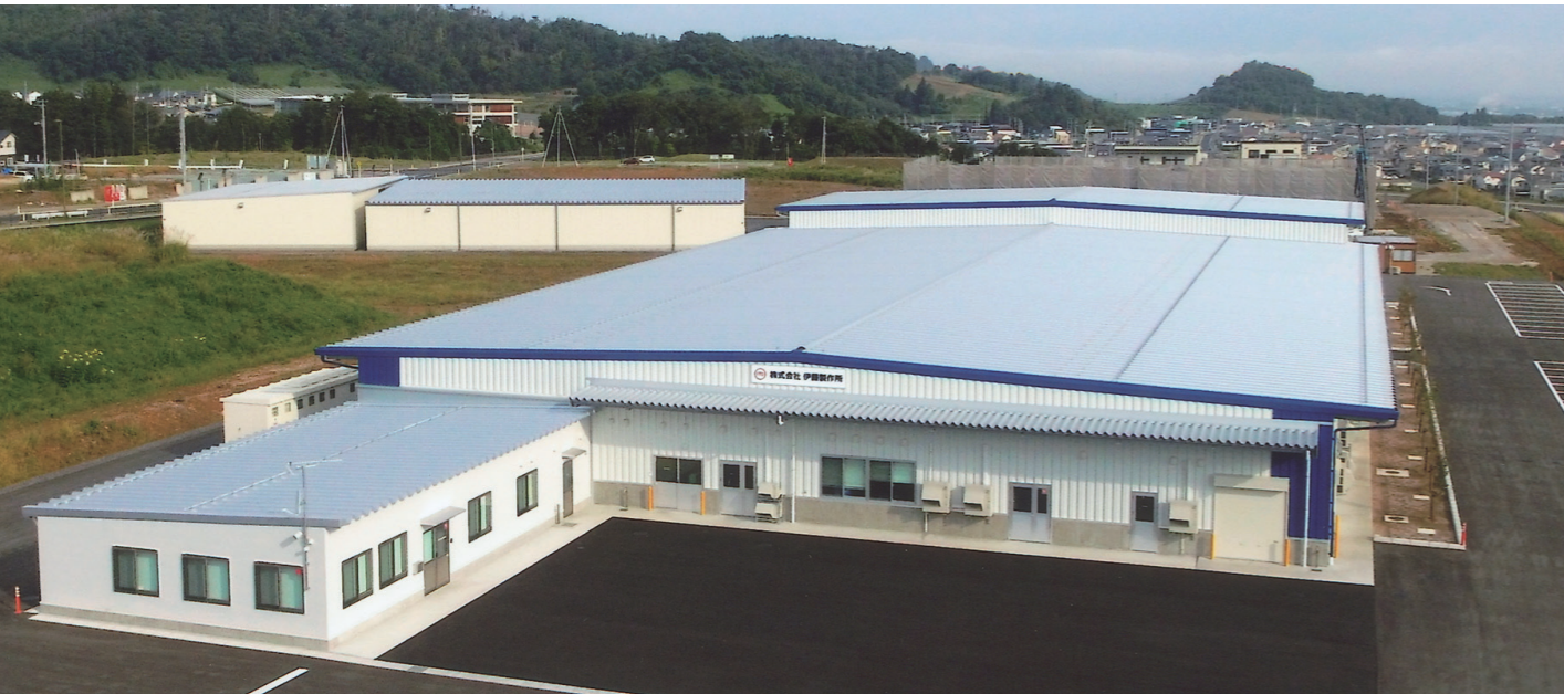
(写真左)山形市のニュータウンみはらしの丘の産業エリアに建設された新工場。 (同右)新工場を視察研修する山形県工業会村山支部のメンバー(1月18日)
