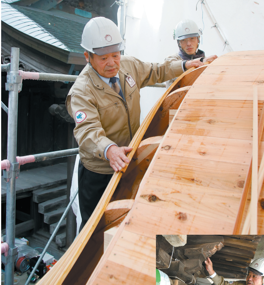
山形・宮町の鳥海月山両所宮中門の屋根修復工事。唐破風と呼ばれる左右両端が反り返った屋根の曲面に沿って細長い木を納めていく「現代の名工」樋口氏。写真下は山形市蔵王成沢の源福寺の新築工事。「若い人たちに伝統の技術を伝えていきたい」と現場で手本を示す
