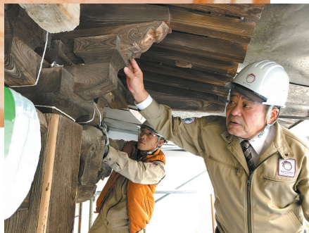
山形・宮町の鳥海月山両所宮中門の屋根修復工事。唐破風と呼ばれる左右両端が反り返った屋根の曲面に沿って細長い木を納めていく「現代の名工」樋口氏。写真下は山形市蔵王成沢の源福寺の新築工事。「若い人たちに伝統の技術を伝えていきたい」と現場で手本を示す
